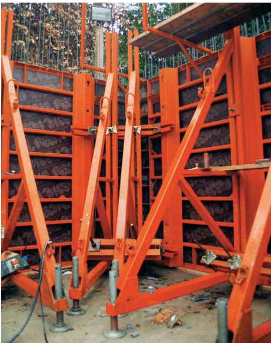
деталь: угловой пояс с контрфорсом 3,00 м для углов  $90^\circ$ .
