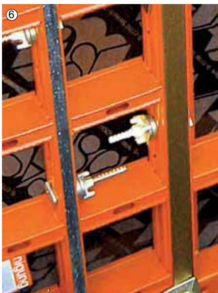
В качестве универсального соединительного элемента стяжной винт выполняет самые разные функции при полном сборе опалубки:
