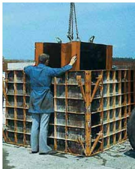
опалубка Растер как опалубка для шахт. Центральная часть исполнена в виде откидного колодца, чтобы гарантировать быструю разборку и повторную сборку опалубки.
