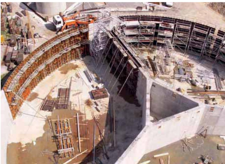
Вот ускорители для возведения опалубки, предлагаемые для опалубки круглых стен с трапециевидными балками марки PASCHAL:
