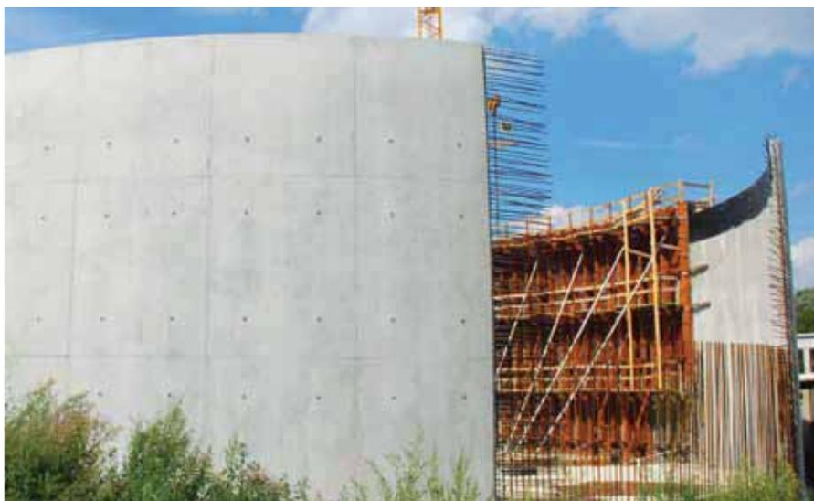
Если температура свежего бетона  $T_{с,при\ заливке}$  не соответствует эталонной температуре  $T_{с,Ref}$ , которая берется за основу при расчете времени завершения схватывания  $t_E$ , то давление свежего бетона необходимо изменить соответствующим образом. При этом температура свежего бетона не должна отклоняться от эталонной температуры более, чем 10 К для бетонных смесей класса консистенции от F1 до F4 и более, чем на 5 К для классов F5, F6 и SVB.
