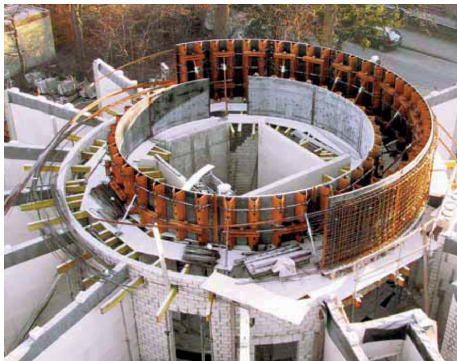
*При постройке проектов надземного строительства зачастую необходимо предусматривать проемы для окон или дверей. На обшивке опалубке толщиной в 21мм, изготовленной из финской березовой фанеры, возможно запросто обеспечить надлежащее крепление.*
