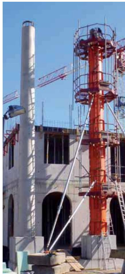
Конусные круглые колонны: жестко смонтированные рабочие площадки с лестницами служат в качестве страховки при бетонировании и распалубке.
