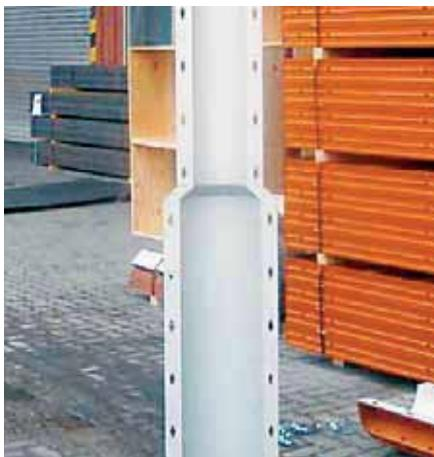
Для сужения круглой опоры была смонтирована коническая промежуточная деталь.
