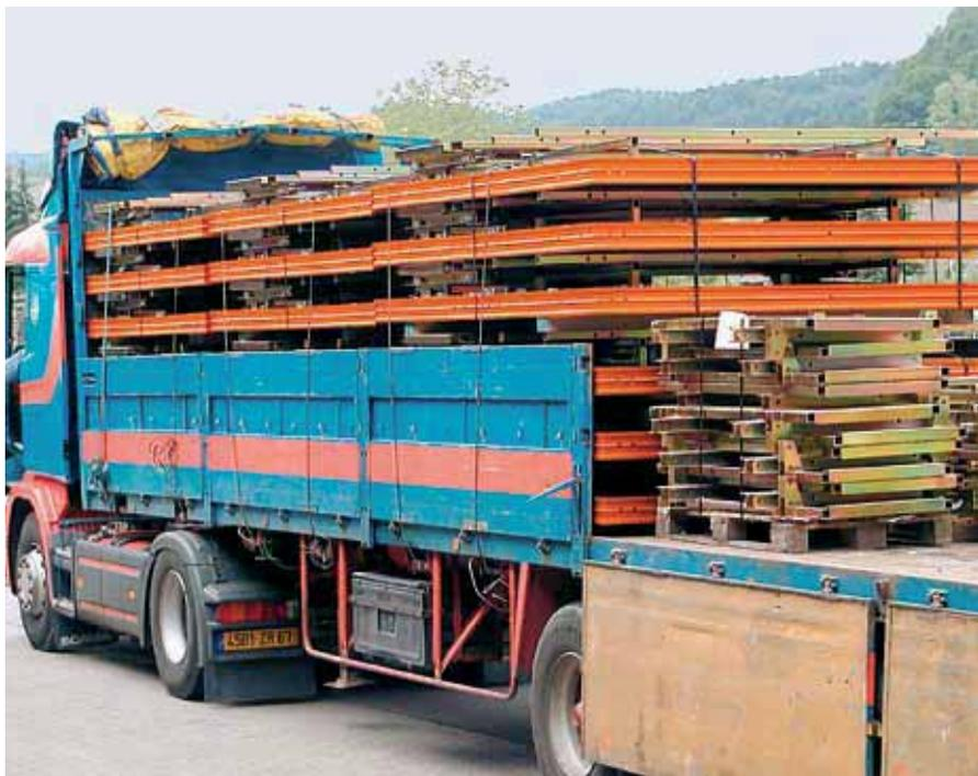
Собранные блоки из опалубочных элементов и лесов готовы к транспортировке.
