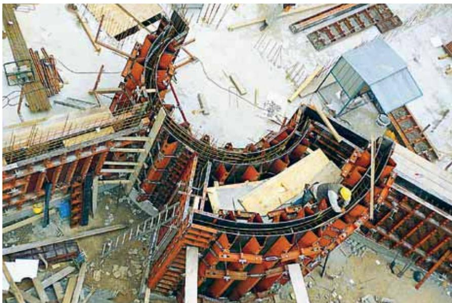
Если требуется обеспечить абсолютную круглость для стен, лестничных клеток или шахт подъемников и лифтов, то чемпионом является опалубка круглых стен с трапецидальными балками фирмы PASCHAL
