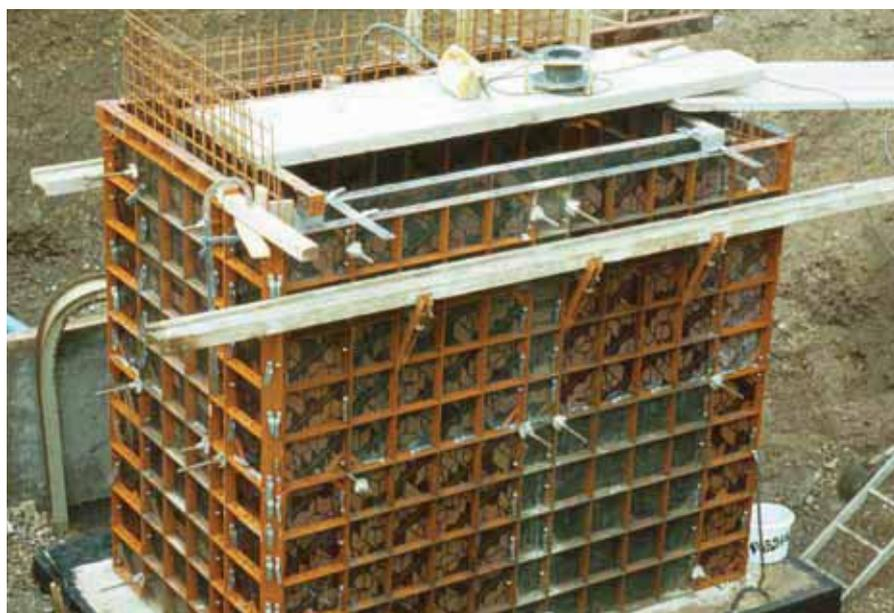
*в таких подземных колодцах опалубка Растер может в полной мере проявить свои способности. Ее применение поможет Вам сэкономить работы по изготовлению дополнительной опалубки, неизбежные при использовании других систем. Вы можете систематически сооружать опалубку для сложного колодца с точностью до сантиметра и с экономией времени.*
