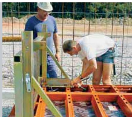
После предварительной сборки т.е. раскрытия площадок лесов опалубка устанавливается вместе с площадками и упорами.
