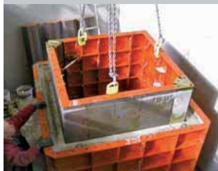
Стальная опалубка без стяжных отверстий для лифтовых и световых шахт
