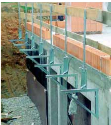
Для бетонирования консолей упор может быть смещен на 50 см.
