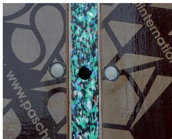
Более широкие пластмассовые компенсаторы имеют стяжные отверстия посередине, чтобы при небольшой поверхности элемента можно было вставить необходимый стяжной стержень точно по центру между опалубочными элементами.
