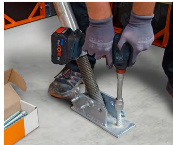
La vis à béton peut être vissée sans problème dans la surface en béton.
