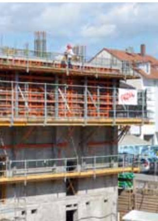
PASCHAL offre avec des consoles grimpantes innovantes flexibles bien au point des solutions qui s'adapteront parfaitement à des situations de construction plus spéciales et qui apporteront un gain en flexibilité et en temps. Les consoles grimpantes de PASCHAL peuvent être combinées à tous les systèmes de coffrage.
