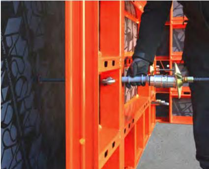
Pour le serrage unilatéral, la tige avec le tube, la douille de guidage et la contre-plaque à rotule sont vissés dans l'unité de serrage du coffrage extérieur.
