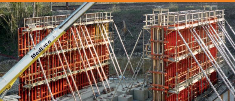
La Multip de PASCHAL correspond aux normes de sécurité les plus élevées et augmente l'efficacité du travail lors du coffrage et du bétonnage. Le montage s'effectue rapidement et confortablement sur l'élément de coffrage couché, ce qui réduit considérablement les situations à risque. Une fois la Multip fixée sur le coffrage, il suffit de déplier le système.
