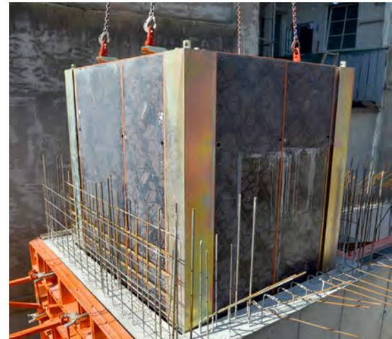
Pour la mise en place du coffrage intérieur, quatre crochets de grue du système de coffrage utilisé sont nécessaires.
