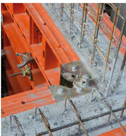
Processus de bétonnage avec angle intérieur de décoffrage fermé
