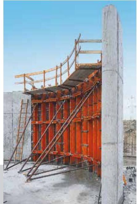
Kläranlage, A-Bad Vöslau; Fa. Ilbau, A-Wien
