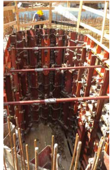
Wohnanlage, Berlin; Fa. JERO Ingenieurbau GmbH, Berlin
