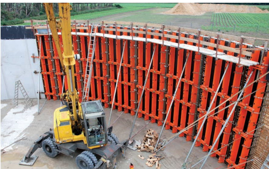
Biogasanlage, Meppen; Baugeschäft H. Wösten GmbH, Haren-Altendorf
