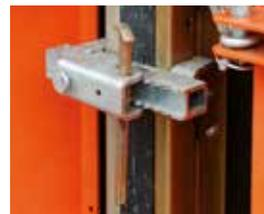
Kunststoffausgleiche werden einfach mit Standardverbindungsmiteln befestigt, z.B. mit der TTK Multiklammer.
