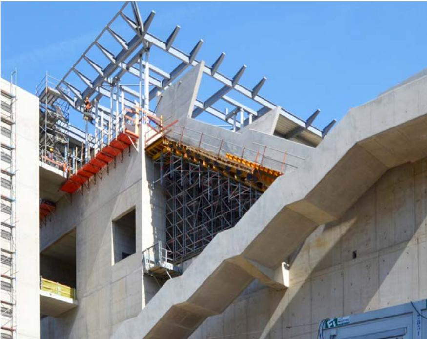
Bei geneigten Decken oder Unterzügen bzw. bei Treppenläufen können die eingesetzten Türme entsprechend der vorgegebenen Neigung unterschiedlich in der Höhe kombiniert und angepasst werden.
