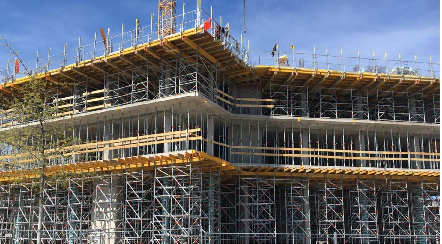
Das Baukastenprinzip des Traggerüstsystems PASCHAL TG 60 ermöglicht die Anpassung an jede Bauwerksgeometrie und an unterschiedliche Schal- bzw. Unterstützungshöhen.
