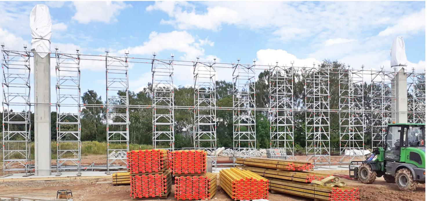
Linienförmige Bauteile wie Unterzüge benötigen das Traggerüst nur in einer Achse. Die einzelnen Türme in ihrer Größe und ihrem Abstand werden entsprechend der Belastung geplant.
