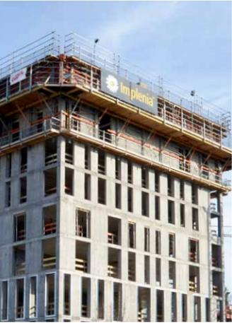
Mit ausgereiften flexiblen Kletterkonsolen bietet PASCHAL Lösungen an, die sich perfekt auch an speziellere Bausituationen anpassen lassen und damit ein Plus an Flexibilität und Zeitersparnis bringen. Die Kletterkonsolen von PASCHAL können mit allen Schalsystemen kombiniert werden.
