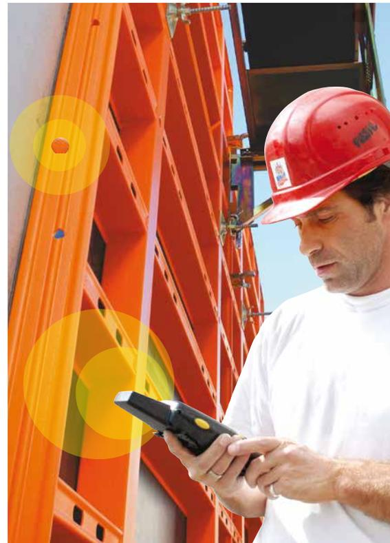
*Die PASCHAL Ident-Technologie verleiht jedem Schalungselement eine elektronische Nummer und somit Unverwechselbarkeit, vergleichbar dem menschlichen Fingerabdruck.*
