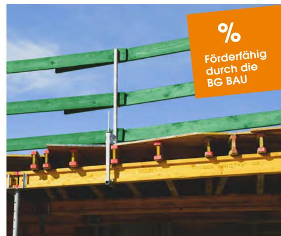
Das Seitenschutzsystem Secuset lässt sich effektiv und sicher an den Holzträgern H20 montieren.
