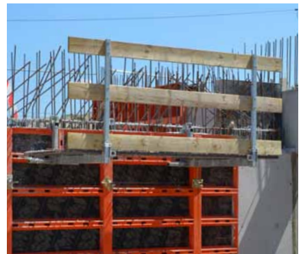
Die Betonierbühnen können für Transporte oder Lagerung platz sparend zusammen geklappt werden.
