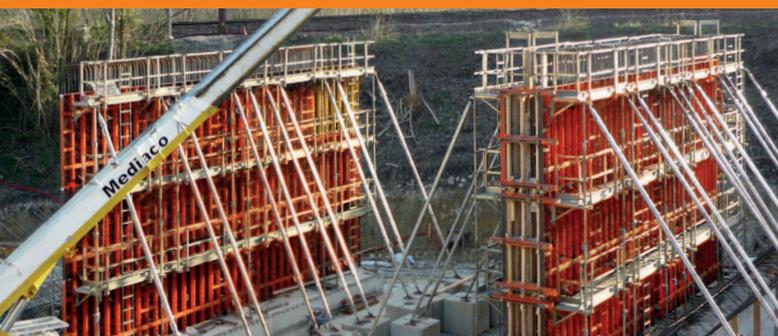
Die Multip von PASCHAL erfüllt höchste Sicherheitsstandards und erhöht die Arbeitseffizienz beim Schalen und Betonieren. Die Montage erfolgt schnell und bequem am liegenden Schalungselement, wodurch sich Gefahrensituationen erheblich reduzieren. Nach dem Befestigen der Multip an der Schalung wird das System lediglich aufgeklappt.
