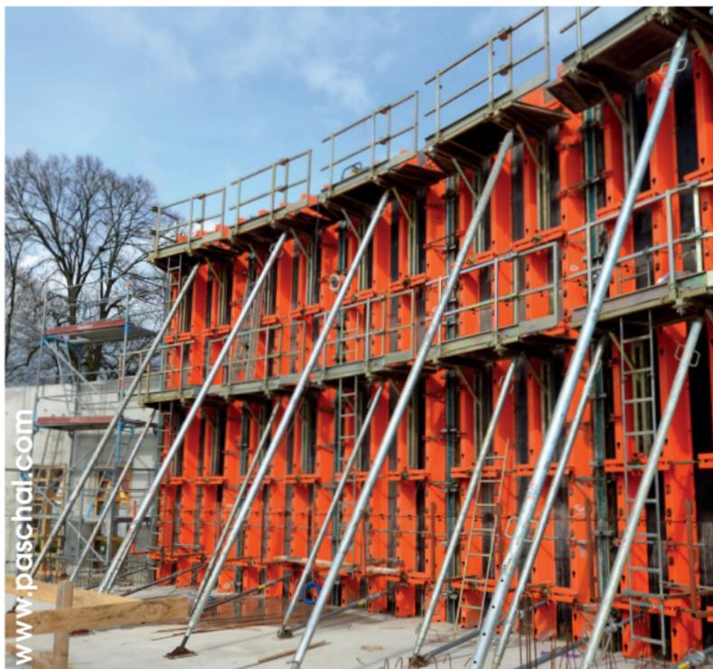
**Trapezträger-Rundschalung mit Klammerverbindung**
