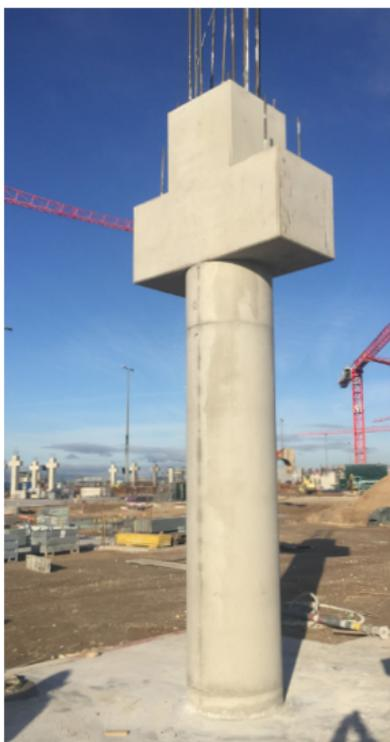
Spezielle objektbezogene Schalungen für Bauteile, bei denen der Einsatz von Systemschalungen nicht oder nur bedingt möglich ist.
