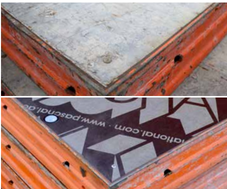
VOR und NACH der Renovierung
