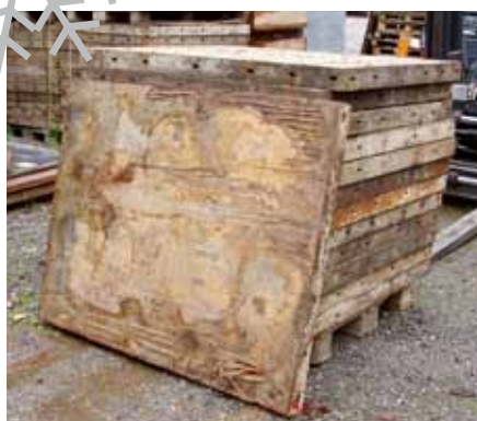
До капитального ремонта
