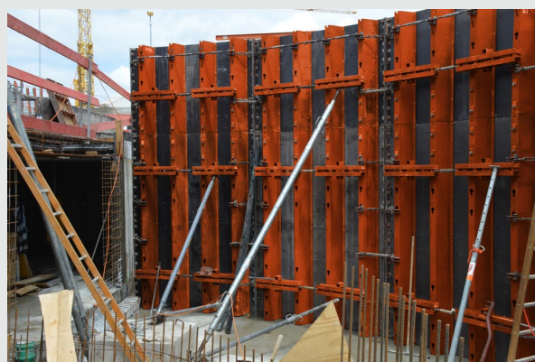
Étai réglable de 175-285 cm sur un chantier à Ringsheim
