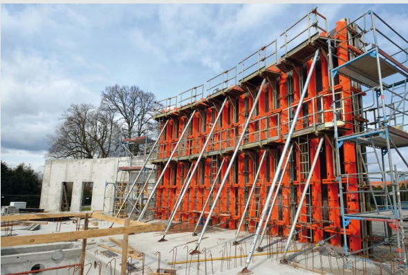
Étai réglable de 400-620 cm sur un chantier à Beinheim
