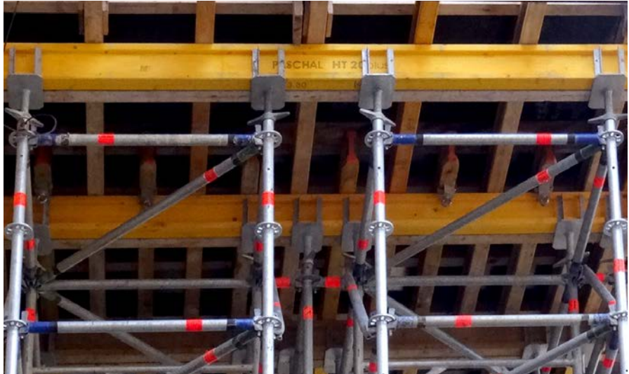
Oberbau mit Spindel, Joch und Querträger
