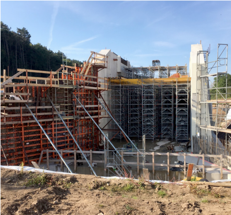
Hochwasserrückhaltebecken Querfurt, Durchlassbauwerk; Umwelttechnik und Wasserbau GmbH, Blankenburg
