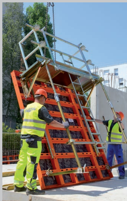
Nach der Vormontage bzw. dem Aufklappen der Beläge wird die Schalung zusammen mit den Bühnen und Abstützungen gestellt.
