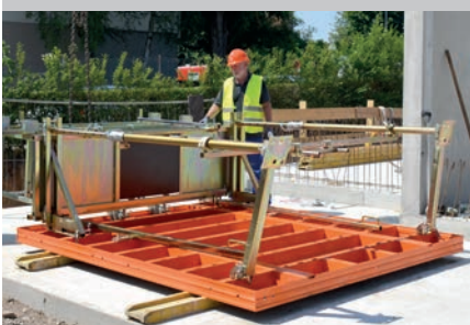
Nach der Vormontage bzw. dem Aufklappen der Beläge wird die Schalung zusammen mit den Bühnen und Abstützungen gestellt.
