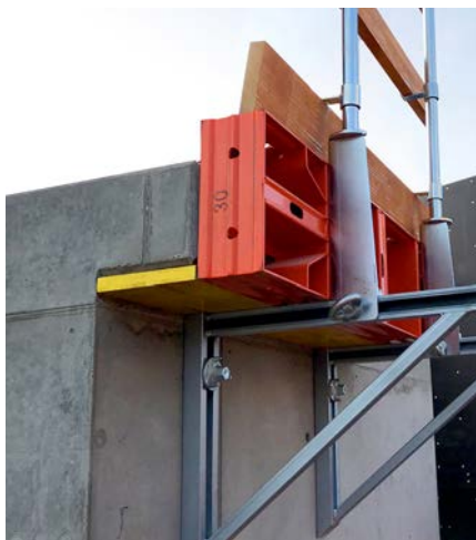
Zum Betonieren von Konsolen kann der Anschlag um 50 cm verschoben werden.
