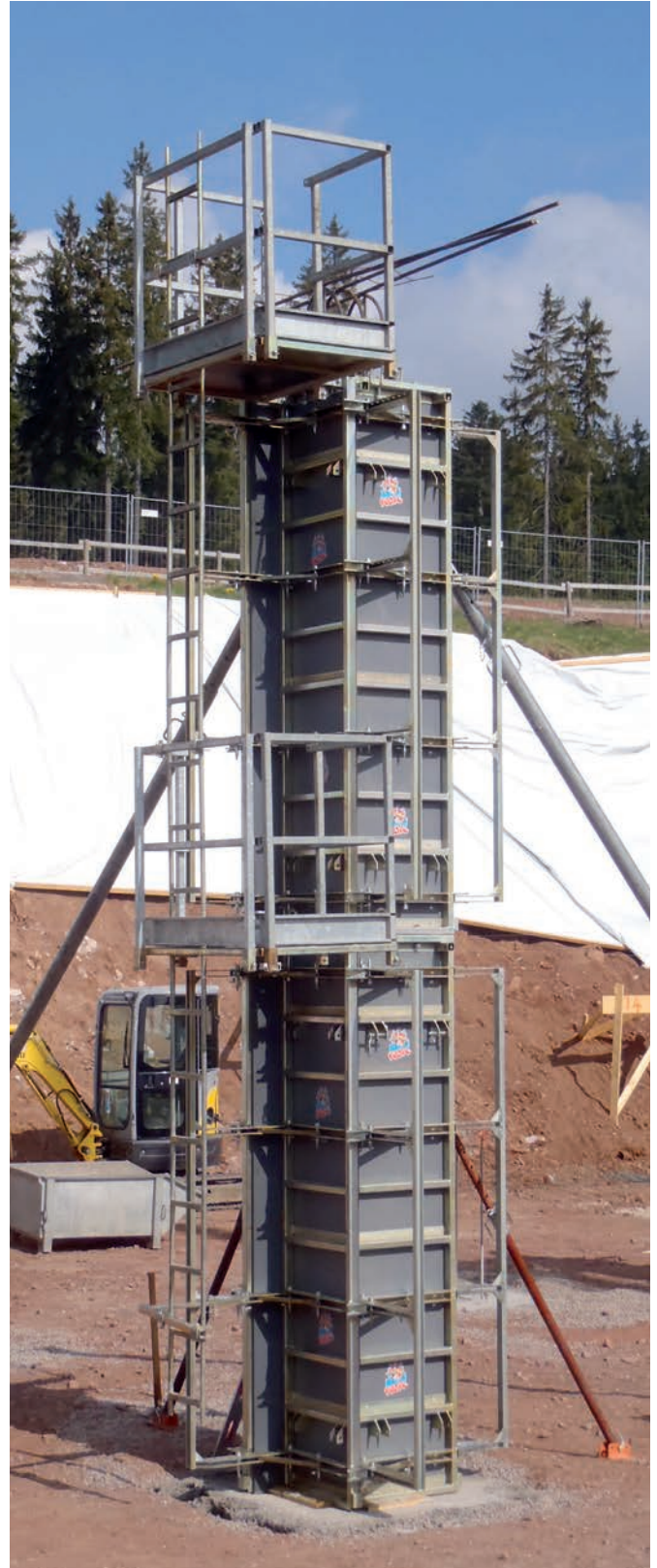
Erweit. Produktionshalle Pfeiffer, Friedenweiler; Baugeschäft Rombach GmbH, Titisee-Neustadt
