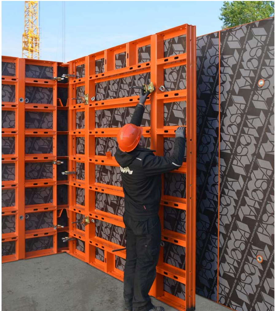
Die einseitige Ankertechnik ermöglicht die Bedienung der Schalungsanker mit nur einer Person.
