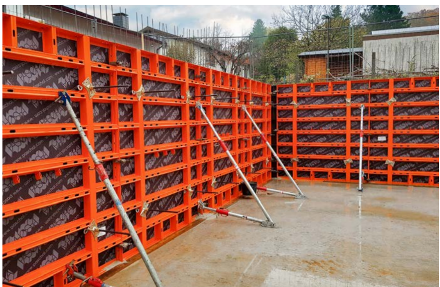
Wohnanlage mit Tiefgarage, Essen-Kettwig; Heinrich Temmink GmbH & Co. KG, Vreden
