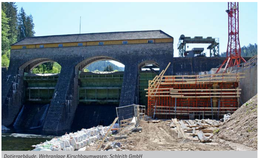
Dotiergebäude, Wehranlage Kirschbaumwasen; Schleith GmbH
