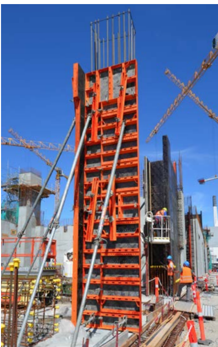
Müllverbrennungsanlage „Amager Bakke“, DK-Kopenhagen; NCC, DK-Kopenhagen
