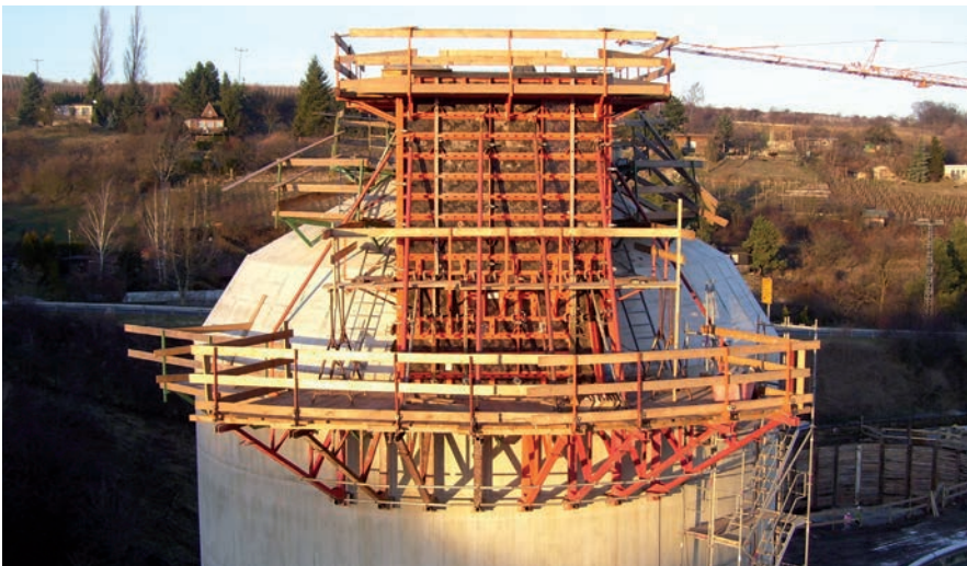
Kläranlage - Erweiterung des Faulturmes, Rollsdorf; beton & rohrbau GmbH & Co.KG, Halle
