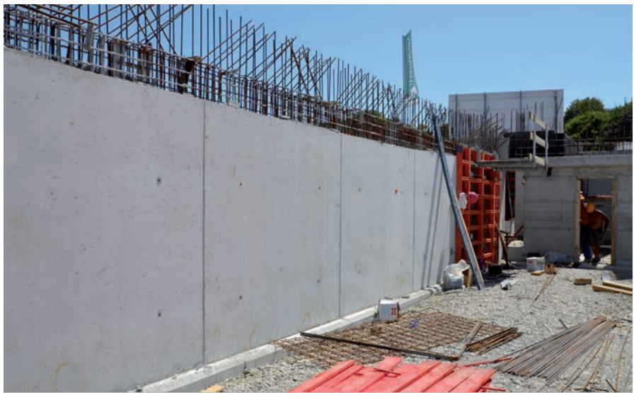
Wohnanlage, München; Seb. Pöttinger GmbH & Co. KG Bauunternehmung, Ottobrunn
