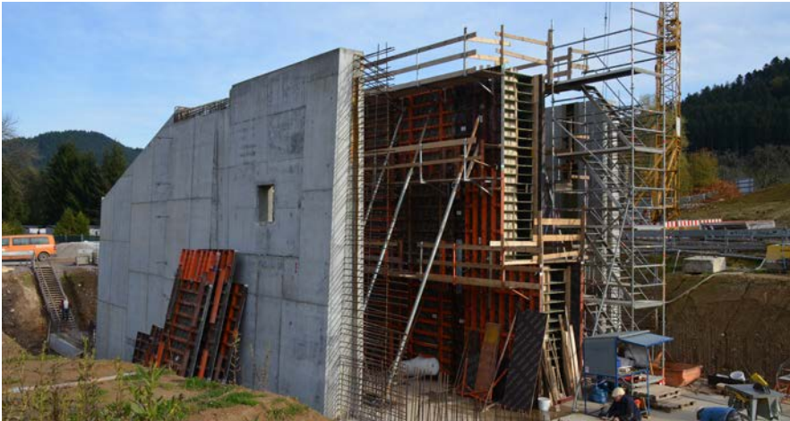
Hochwasserrückhaltebecken, Steinach; Vogel-Bau GmbH und Meurer-Bau GmbH & Co. KG
