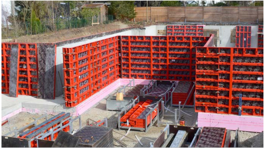
Wohnhaus, München; Bau-Dosch GmbH, Seefeld
