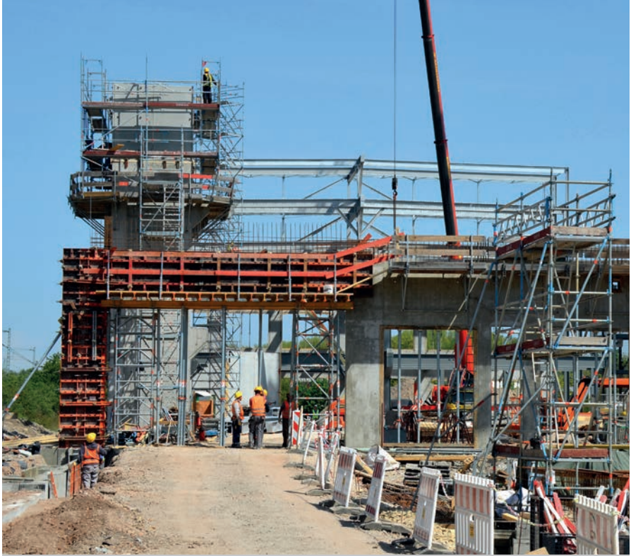
Mobilitäts-Zentrums, Karlsruhe; Züblin, Bereich Ingenieurbau Karlsruhe
