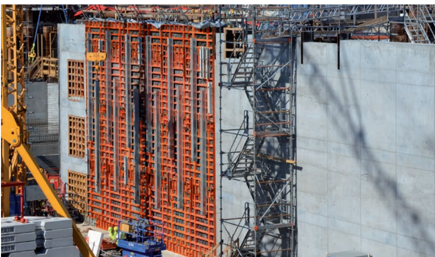
Unterwassertiefgarage, DK-Kopenhagen; NCC, DK-Kopenhagen
