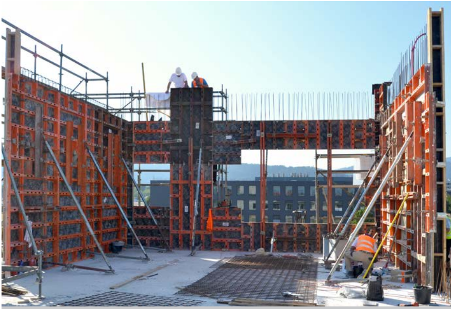
Forschungsgebäude IMBIT, Universität Freiburg; Implema AG
