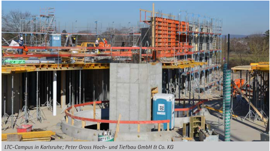
LTC-Campus in Karlsruhe; Peter Gross Hoch- und Tiefbau GmbH & Co. KG
