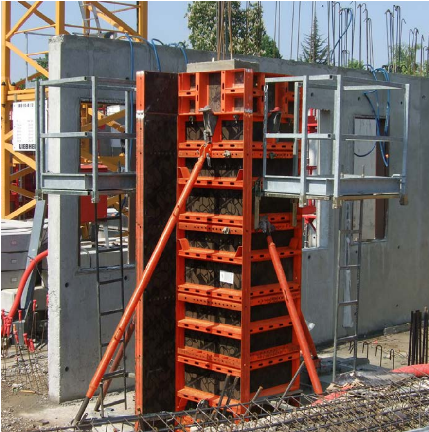
Krankenhaus, F-Straßburg; Eiffage Construction Alsace, F-Oberhausbergen
