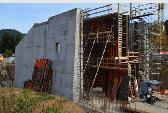
Richtstrebe 620-1000 cm auf einer Baustelle in Welschensteinach
