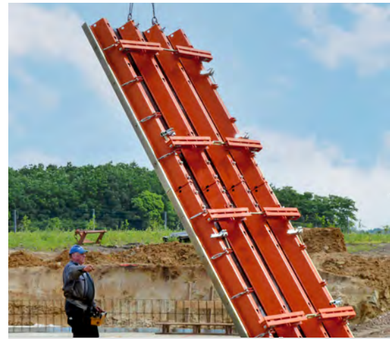
Die Klammern werden beim Ausschalen am Segment „geparkt“ und sind beim nächsten Einsatz sofort griffbereit.
