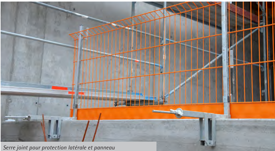
Serre joint pour protection latérale et panneau
