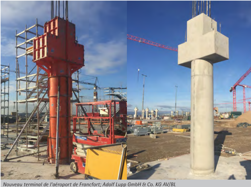
Nouveau terminal de l'aéroport de Francfort; Adolf Lupp GmbH Et Co. KG AV/BL
