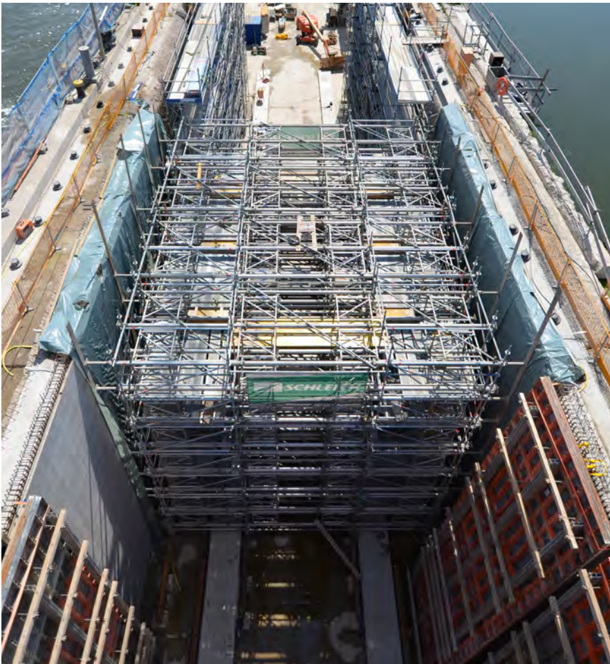
Assainissement d'une écluse, D-Lauffen; Schleith GmbH & RSW RoBlauer Schiffswerft GmbH & Co KG
