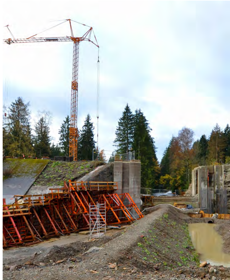
Rénovation générale du bassin côté aval du barrage de Söse; Umwelttechnik & Wasserbau GmbH, D-Blankenburg
