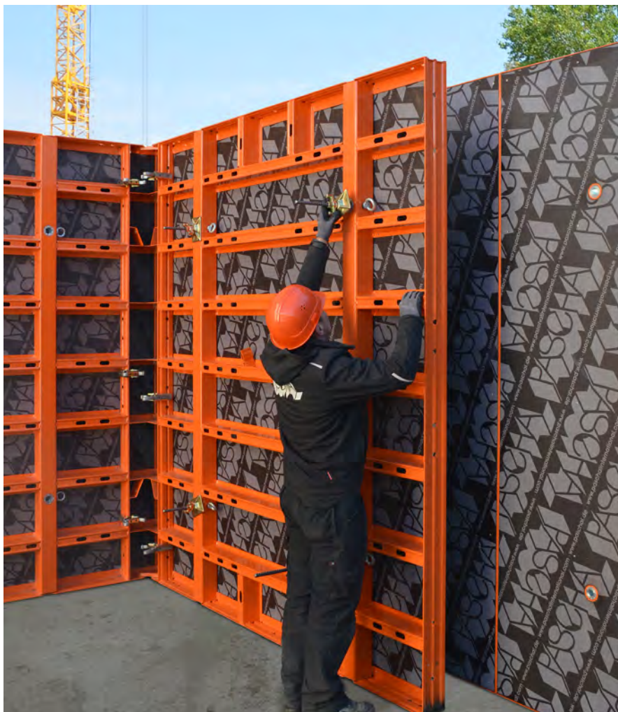
La technique d'ancrage unilatérale permet la manipulation des tiges de coffrage par une seule personne.
