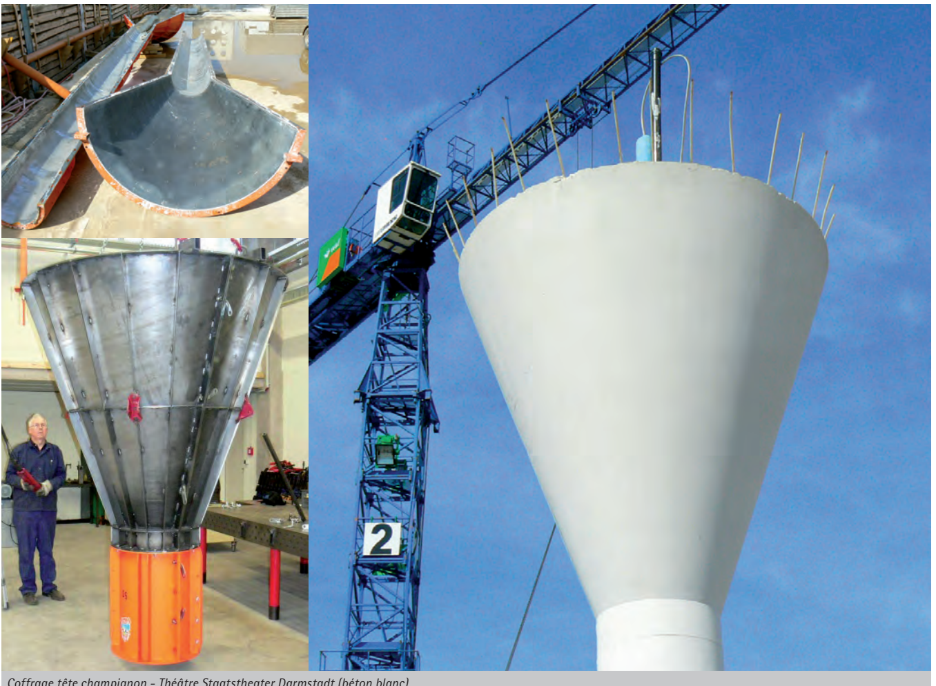
Coffrage tête champignon - Théâtre Staatstheater Darmstadt (béton blanc)
