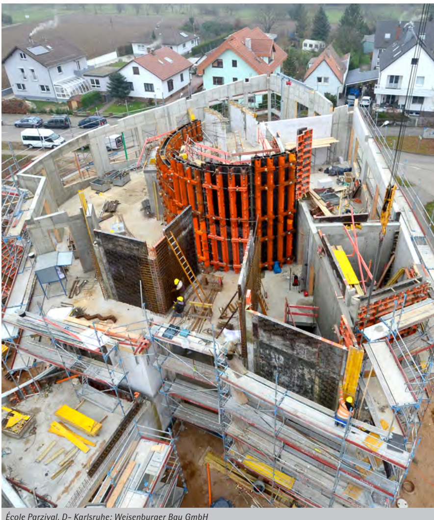
École Parzival, D- Karlsruhe; Weisenburger Bau GmbH
