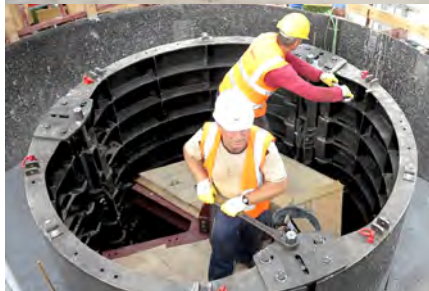
Le mécanisme de décoffrage manuel peut être actionné par un mécanisme à broche conçu par PASCHAL.
