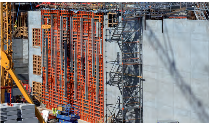
Parking souterrain, DK-Copenhague ; Sté. NCC, DK-Copenhague
