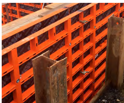
L'unité de serrage forme une surface plane avec le cadre de l'élément.
