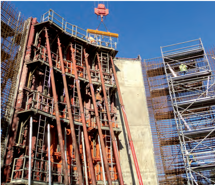
Station d'épuration, F-Chambéry; Sté. Eiffage TP Agente Rhone Alpes, F-Lyon
