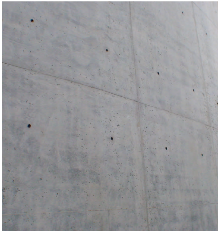
Surface en béton parfaite
