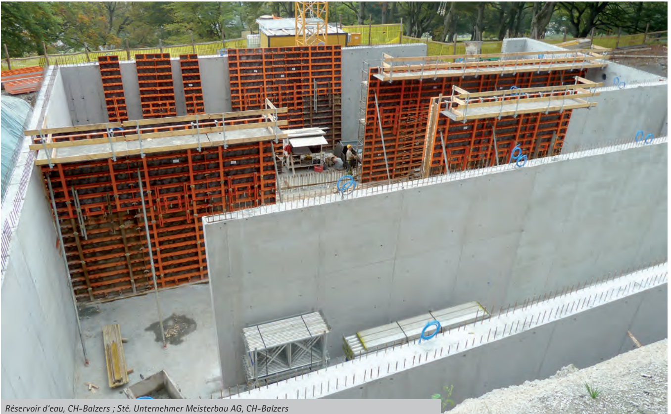
Réservoir d'eau, CH-Balzers ; Sté. Unternehmer Meisterbau AG, CH-Balzers
