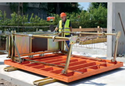
Après le pré-montage et déploiement des platelages, le coffrage, les plates-formes et les étais sont mis en place.
