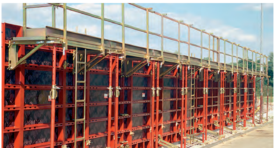
Installation de compostage, F-Pfaffenhofen ; Sté. Krummhorn Sarl, F-Bitschhoffen
