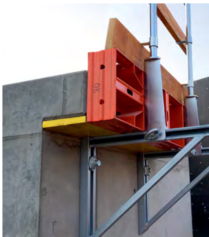
Pour couler des consoles, la butée peut être déplacée de 50 cm.
