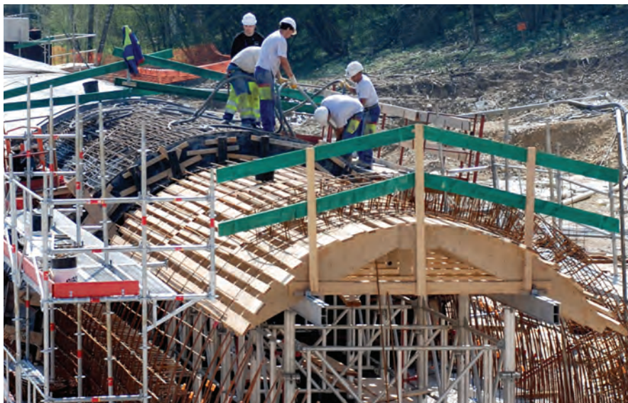
Coffrage de voûte, F-Rougement ; Sté. GTM, F-Les Magny
