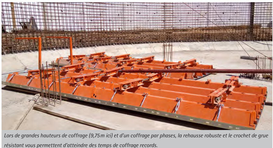
Pièce de rehausse pour poutre trapézoïdale
