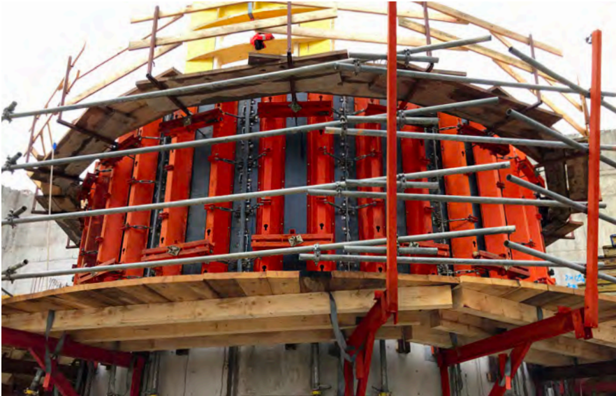
Silo gastronomique avec plate-forme panoramique, CH-Einsiedeln; Föllmi AG, CH-Feusisberg
