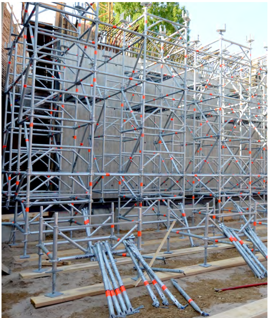
Support de la sous-structure
