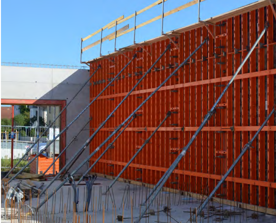
Hall de production, Haslach ; Sté. Singler Bau, Hofstetten
