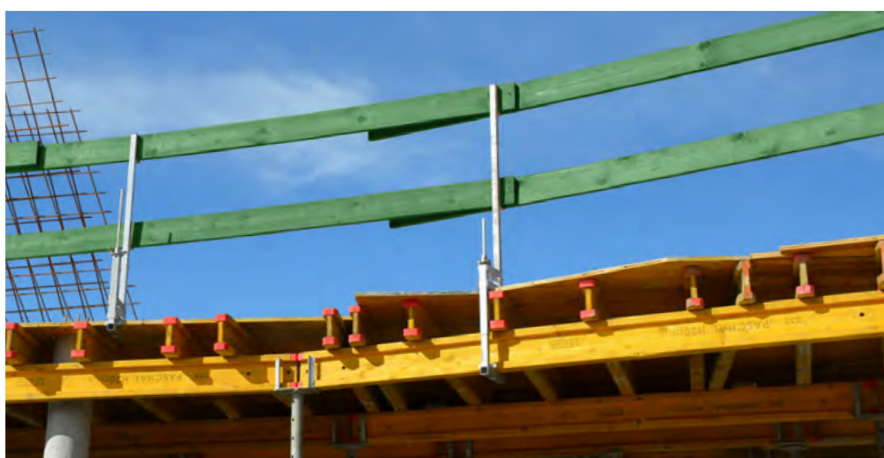
Utilisation sur des coffrages de dalles avec serre joint
