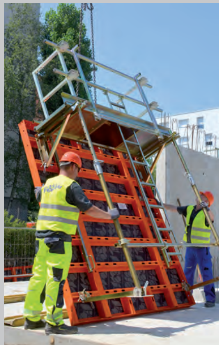
Après le pré-montage et déploiement des platelages, le coffrage, les plates-formes et les étais sont mis en place.
