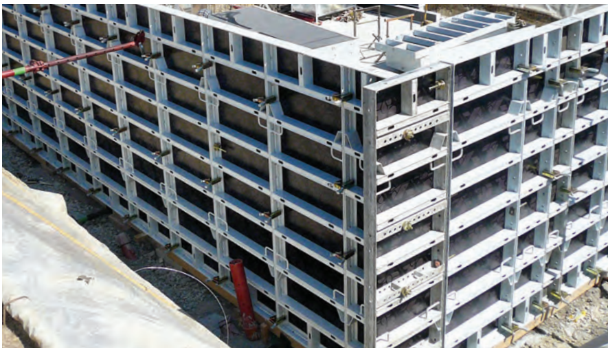
Maison d'habitation, CH-Cortailod ; Fa. Duckert Pierre SA; CH-Areuse
