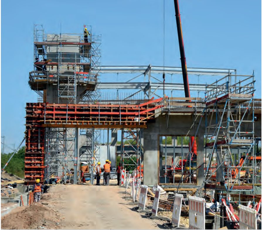
Centre de mobilité, D-Karlsruhe; Züblin, service Génie civil à Karlsruhe
