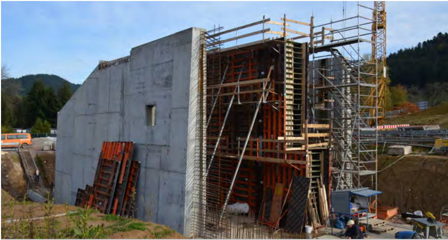
Sous-sol maison d'habitation, Ergolding ; Sté. Lachermeier GmbH, Ergolding
