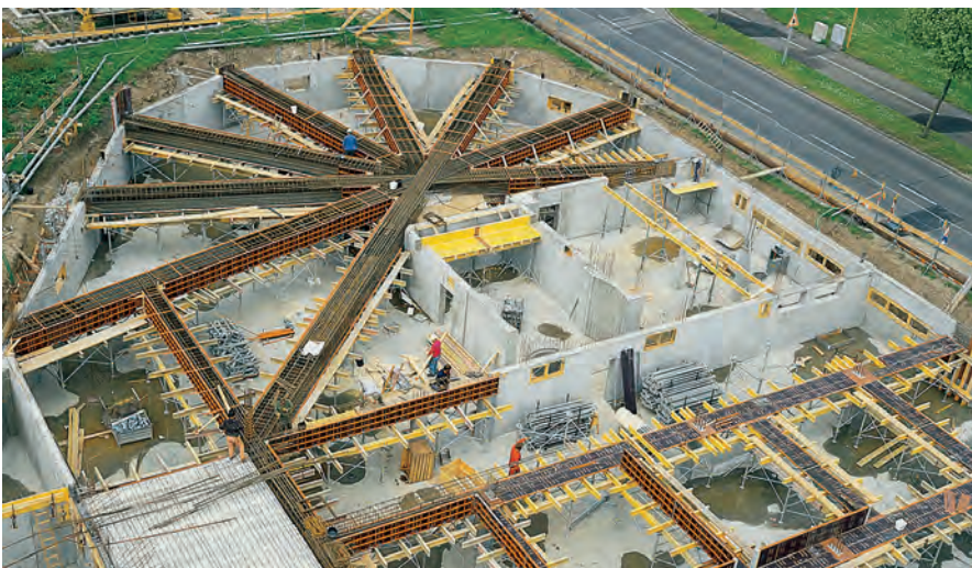
Entrepôt et bâtiment administratif, D-Karlsruhe ; Sté. Dyckerhoff & Widmann AG, D-Karlsruhe
