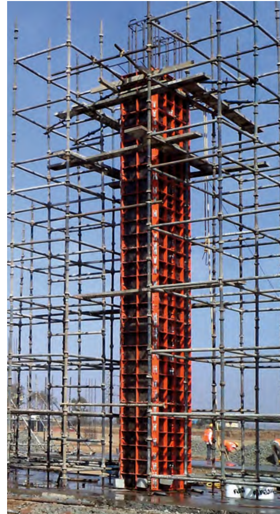
Poteau angulaire, avec éléments Treillis et angles rigides de 135° réalisés sans coffrage spécial coûteux.
