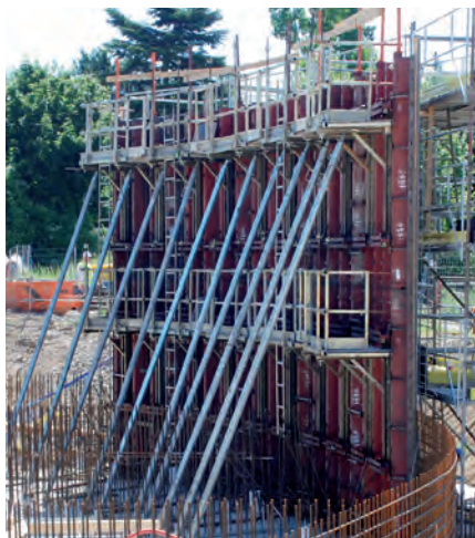
Station d'épuration, F-Chambéry; Sté. Eiffage TP Agente Rhone Alpes, F-Lyon
