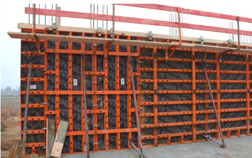
École Parzival, D-Karlsruhe ; Sté. Weisenburger Bau GmbH
