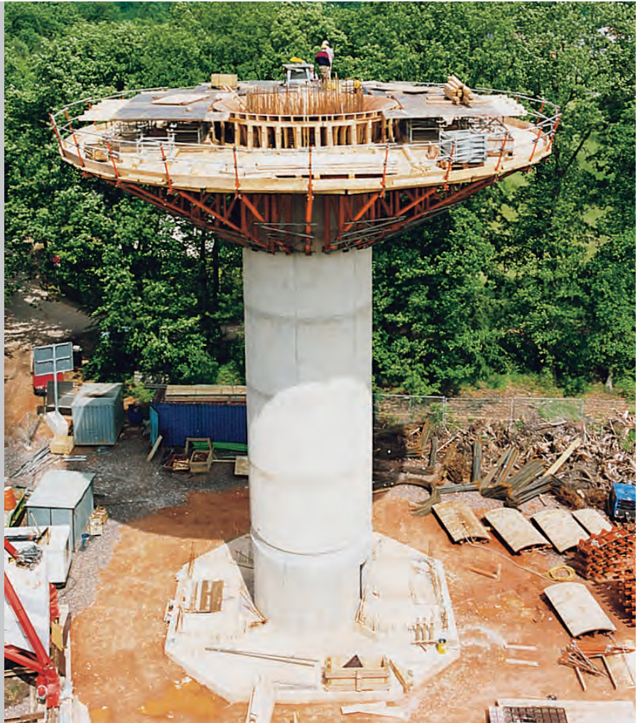
Château d'eau, D-Lauterbach ; Sté. Walter Bau AG, D-Kirkel-Limbach
