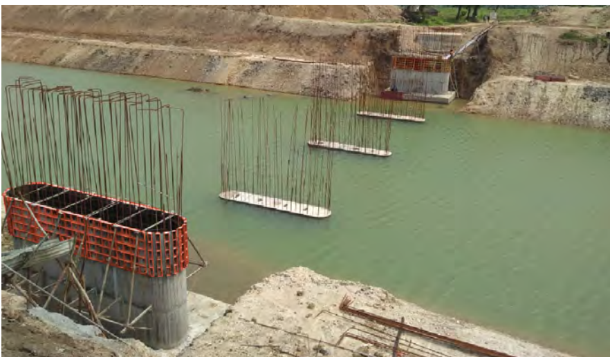
Pont, projet d'irrigation de Sita-Rama; HES Infra Pvt. Ltd., Inde
