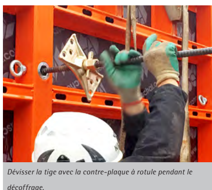
Pour le serrage unilatéral, la tige avec le tube, la douille de guidage et la contre-plaque à rotule sont vissés dans l'unité de serrage du coffrage extérieur.
