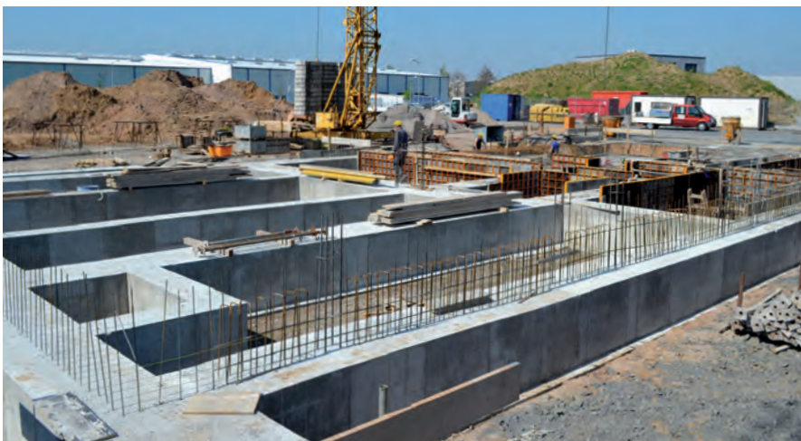
Entrepôt et bâtiment administratif, D-Gelnhausen; Grauel Hoch- u. Tiefbau GmbH & Co. KG, D-Birstein
