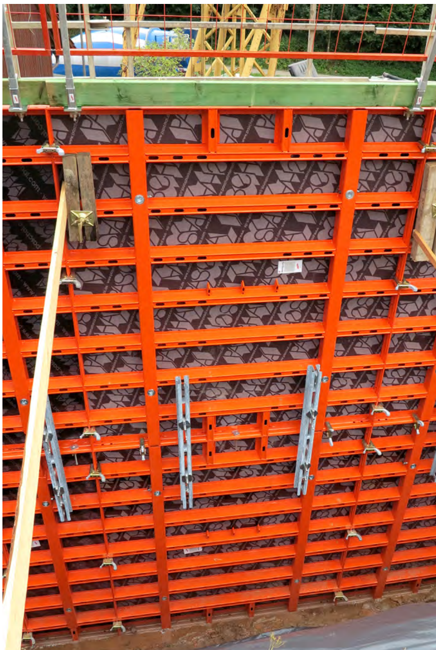
Pour le serrage unilatéral, la tige avec le tube, la douille de guidage et la contre-plaque à rotule sont vissés dans l'unité de serrage du coffrage extérieur.
