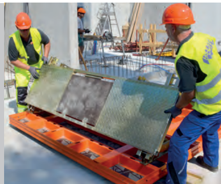
Prêtes au transport : des unités complètement montées comprenant des éléments de coffrage et des plates-formes de travail.
