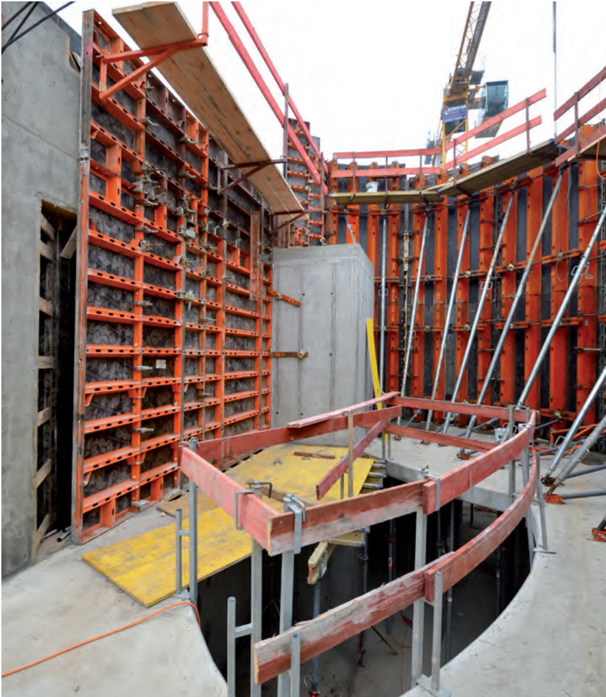
École Parzival, D-Karlsruhe ; Sté. Weisenburger Bau GmbH
