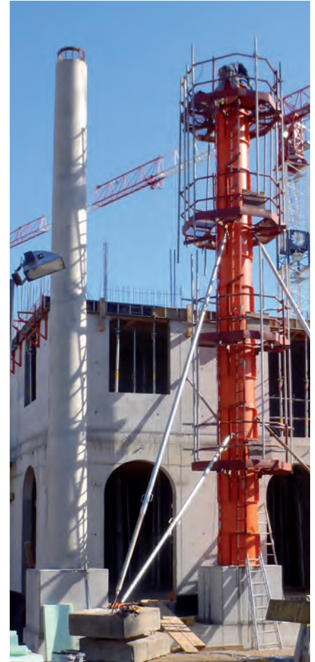
Poteaux coniques : plate-formes de travail intégrées avec échelles d'accès pour coffrer, bétonner et décoffrer en toute sécurité.
