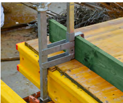
Serre joint pour protection latérale et panneau
