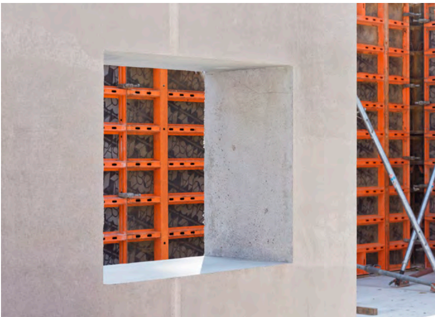
Centre pour la jeunesse „Betonase“, D-Berlin-Friedrichsfelde; E & W BauTec Gbr; Photo: Alexander Blumhoff, alexander-blumhoff.com
