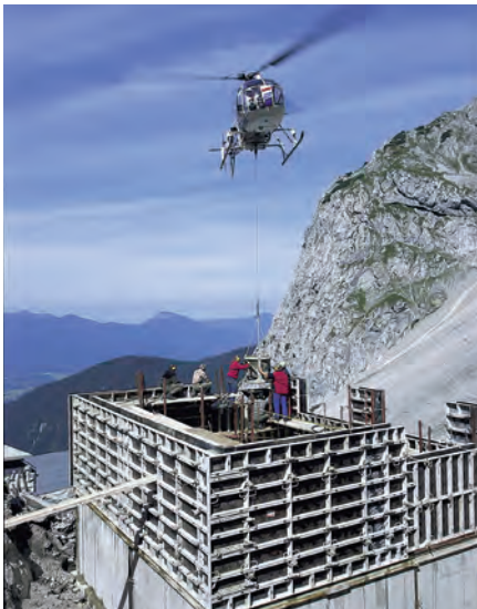
Coffrage de voile LOGO alu Coffrage léger pour chantiers sans grue et complément de LOGO.3
