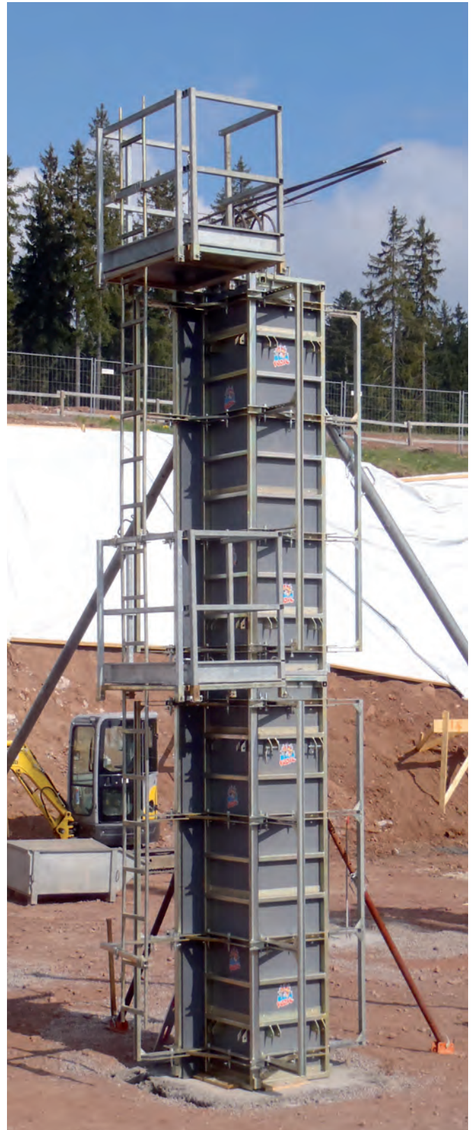
Extension du hall de production Pfeiffer, Friedensweiler ; Ets. de construction Rombach GmbH, Titisee-Neustadt
