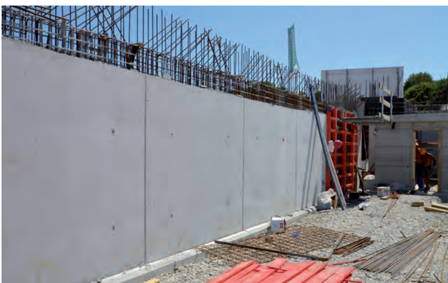
Immeuble d'habitation, D-Munich ; Sté. Seb. Pöttinger GmbH & Co. KG Bauunternehmung, D-Ottobrunn
