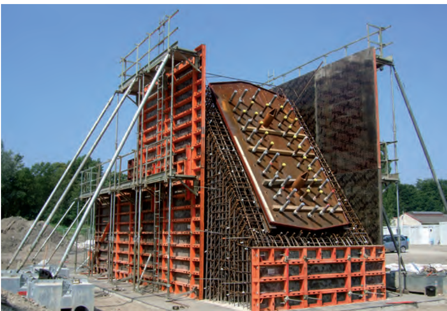
Culée de pont „Pont Citadelle“, F-Straßburg; GTM Halle
