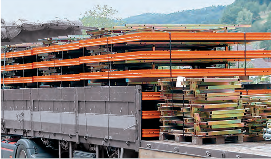
Prêtes au transport : des unités complètement montées comprenant des éléments de coffrage et des plates-formes de travail.
