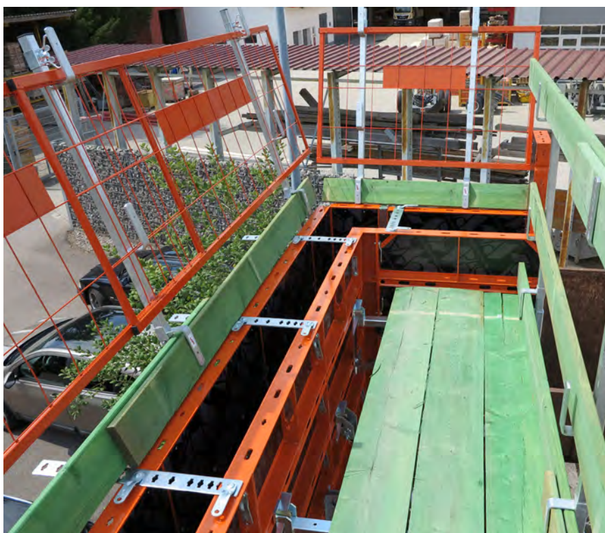
Secuset avec panneau grillagé sur le coffrage NeoR
