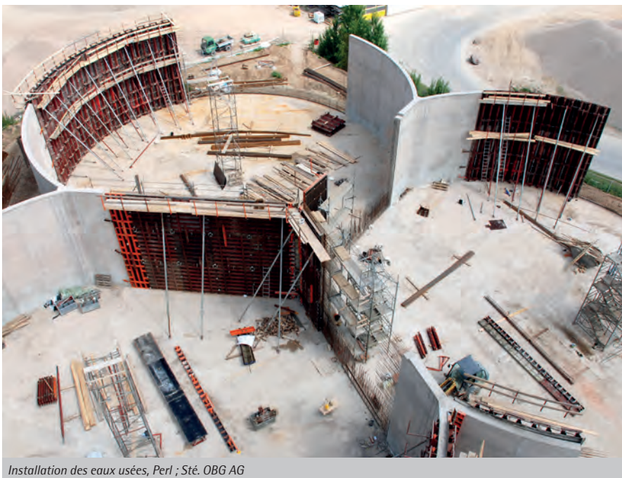
Installation des eaux usées, Perl ; Sté. OBG AG
