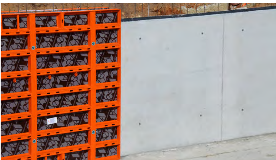
Parements béton impeccables
