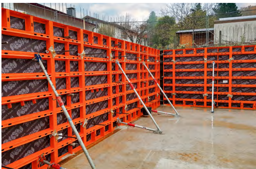
Copropriété avec parking souterrain, Essen-Kettwig; Heinrich Temmink GmbH & Co. KG, Vreden
