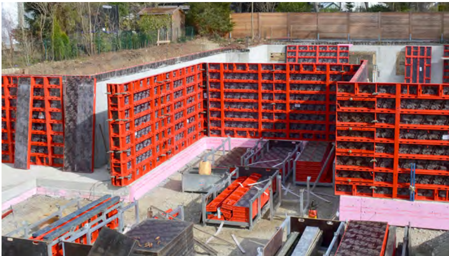
Immeuble résidentiel, D-Munich ; Sté. Bau-Dosch GmbH, D-Seefeld
