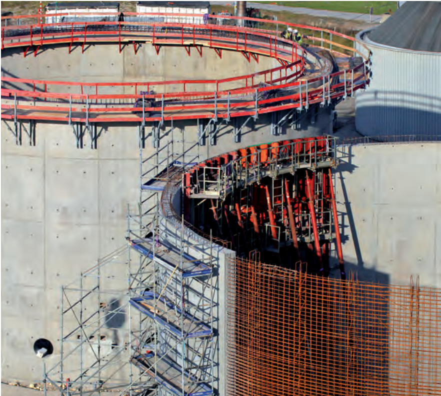
Station d'épuration, F-Chambéry; Sté. Eiffage TP Agente Rhone Alpes, F-Lyon
