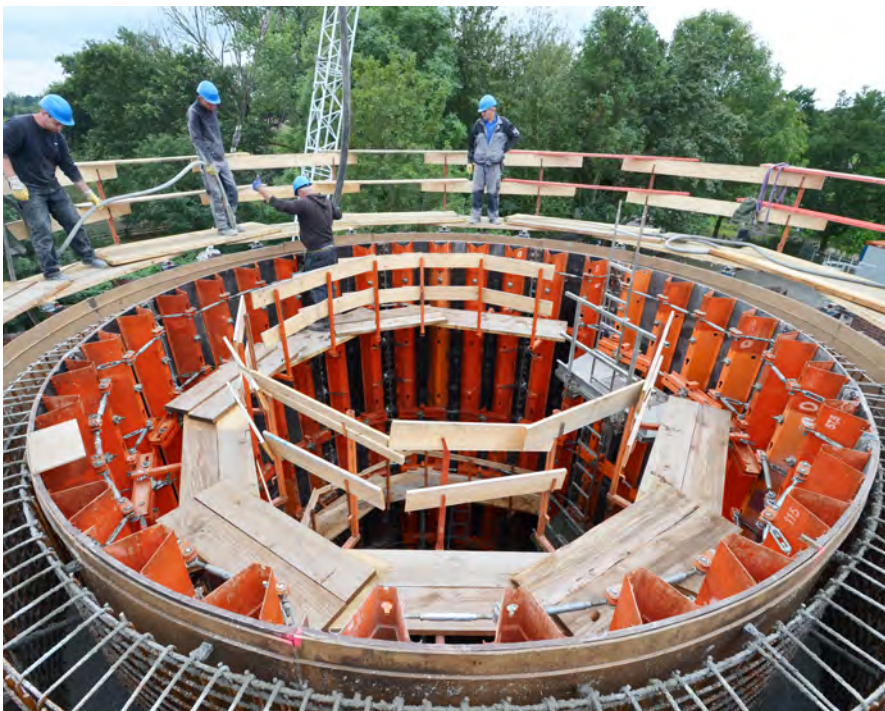
Réservoir d'eau, D-Oberhausen; Uhrig
