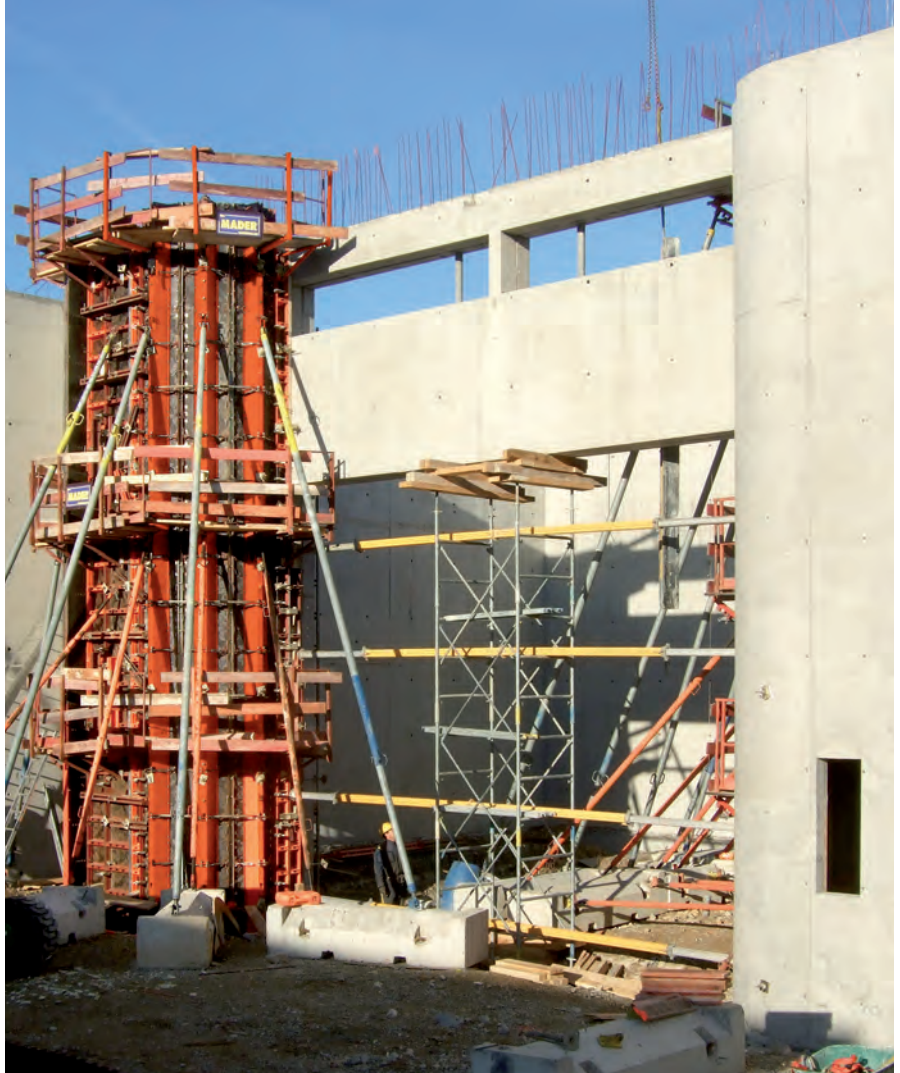
Gymnase , F-Flaxlanden ; Sté. Mader Entreprise Générale de Bâtiment Z.I., F-Guebwiller
