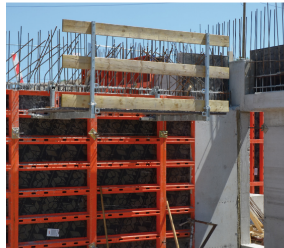
Les plateformes de bétonnage peuvent être repliées lors du transport ou du stockage pour un gain de place.
