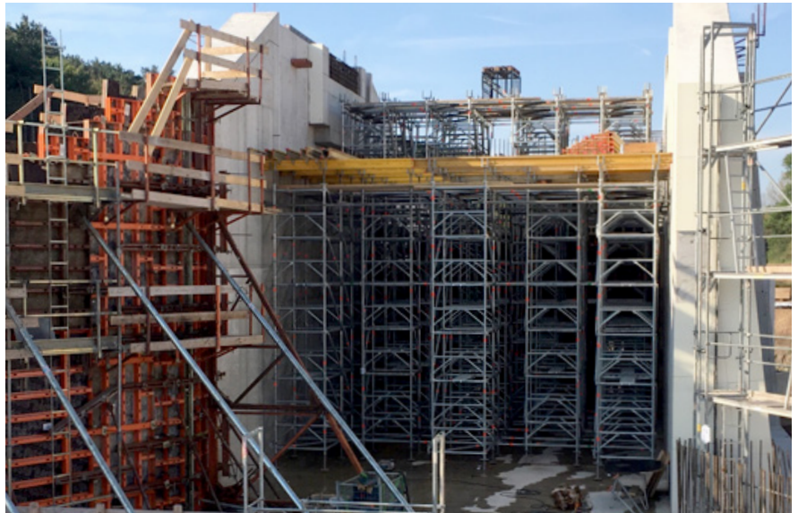
Flood control reservoir, D-Querfurt; Umwelttechnik und Wasserbau GmbH, D-Blankenburg
