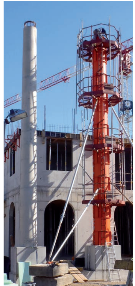
Konische Rundsäulen: Fest montierte Arbeitsplattformen mit Leitern als Zugang dienen der Sicherheit beim Ein- und Ausschalen sowie beim Betonieren.
