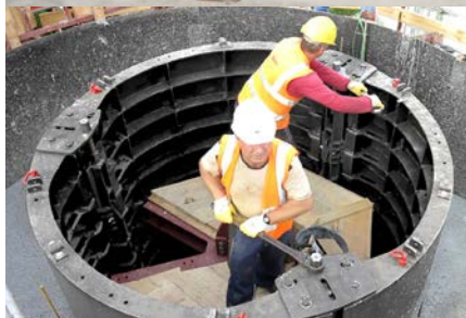
Über eine Spindelmechanik kann der manuelle Ausschalmechanismus betätigt werden.
