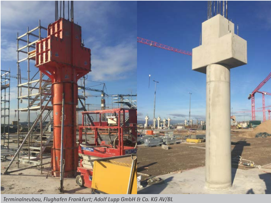
Terminalneubau, Flughafen Frankfurt; Adolf Lupp GmbH & Co. KG AV/BL
