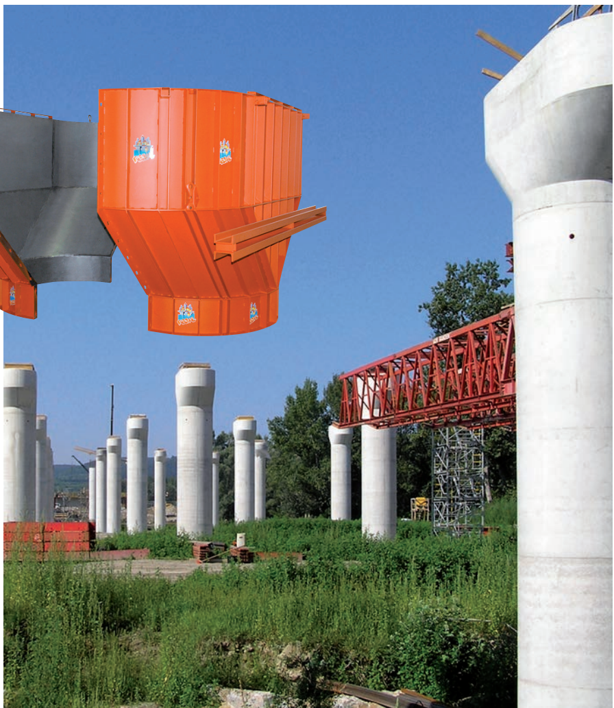
Brückenpfeiler Donaubrücke Traismauer, Verbindung Nord RFB; Alpine Bau GmbH, A-Wien
