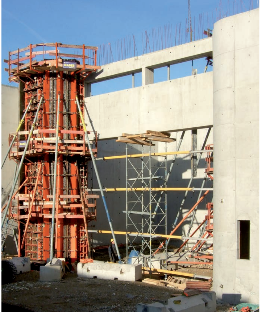
Sporthalle, F-Flaxlanden; Mader Entreprise Générale de Bâtiment Z.I., F-Guebwiller
