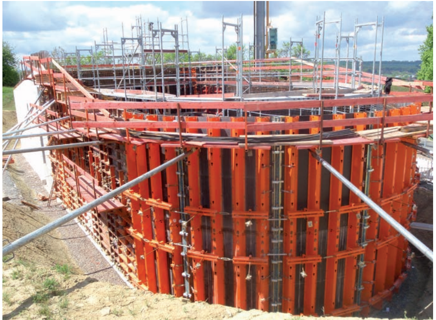
Hochbehälter, Galgenberg; Wolf & Sofsky SF Tief- und Ingenieurbau GmbH, Zweibrücken
