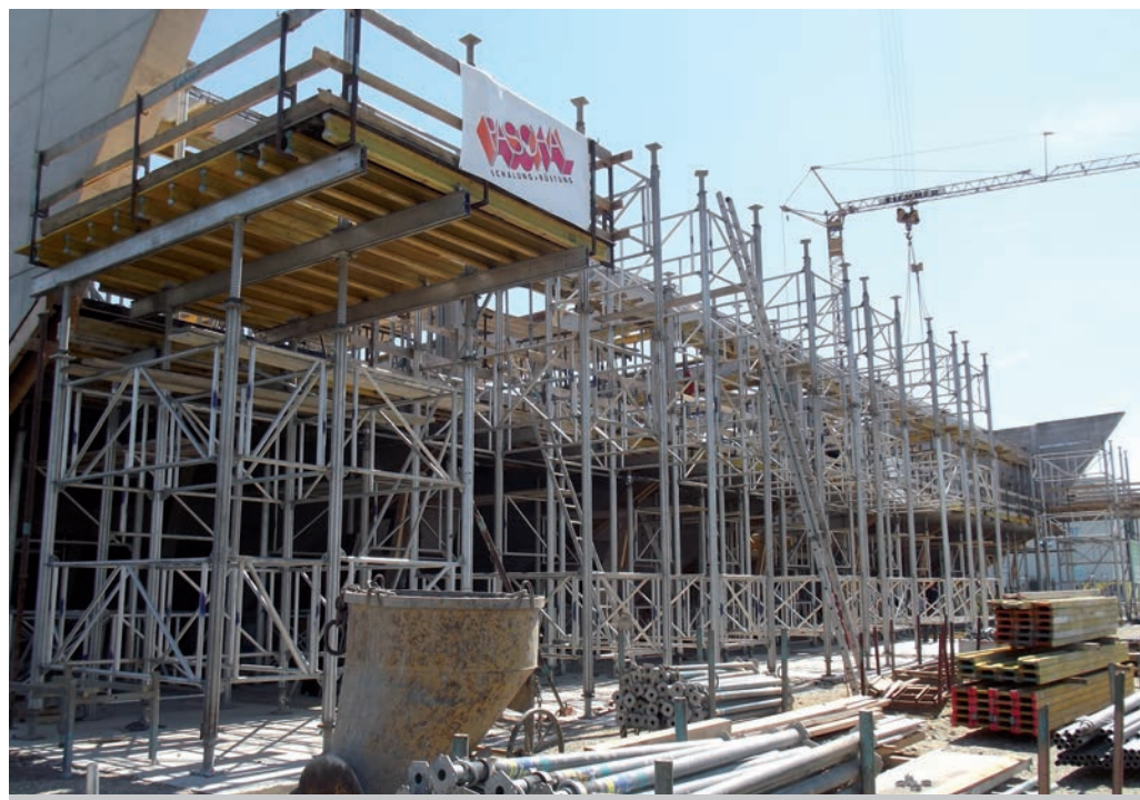
Neubau Hewe-Fensterbau, Lahr; Baugesellschaft Eichner mbH, Lahr
