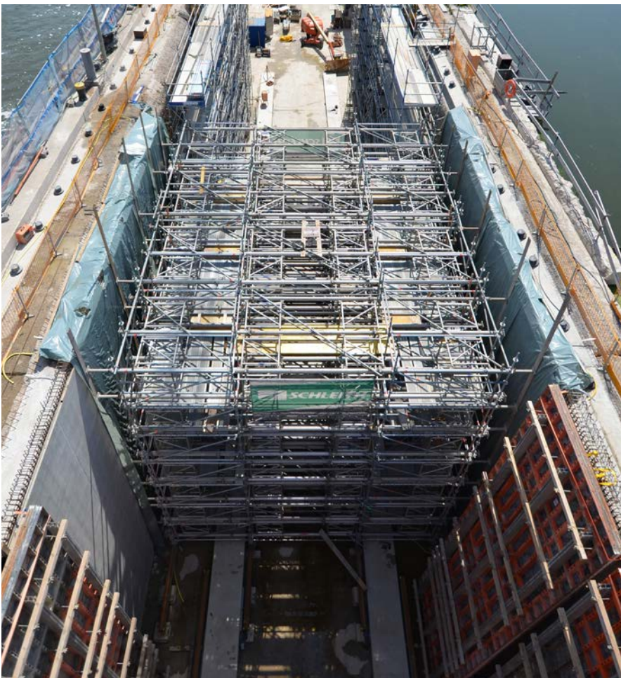
Schleusensanierung, Lauffen; Schleith GmbH, Achem u. RSW RoBlauer Schiffswerft GmbH & Co KG, Dessau-Roßlau
