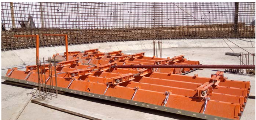
Bei großen Schalhöhen und taktweisem Schalen lassen sich dank der robusten Aufstockung und der besonders tragfähigen Krananhängung Rekord-Schalzeiten erzielen.
