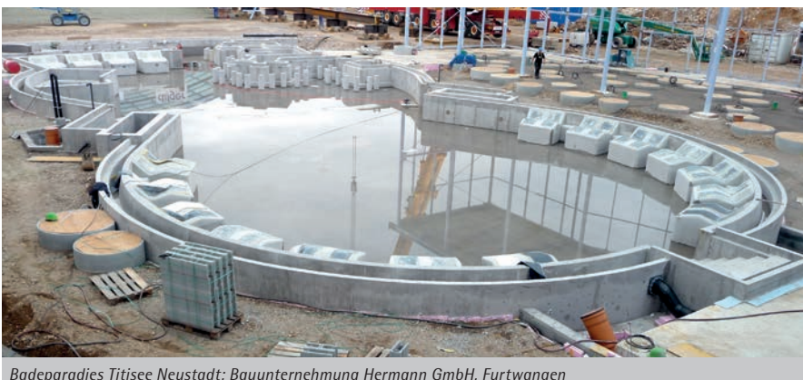
Badeparadies Titisee Neustadt; Bauunternehmung Hermann GmbH, Furtwangen
