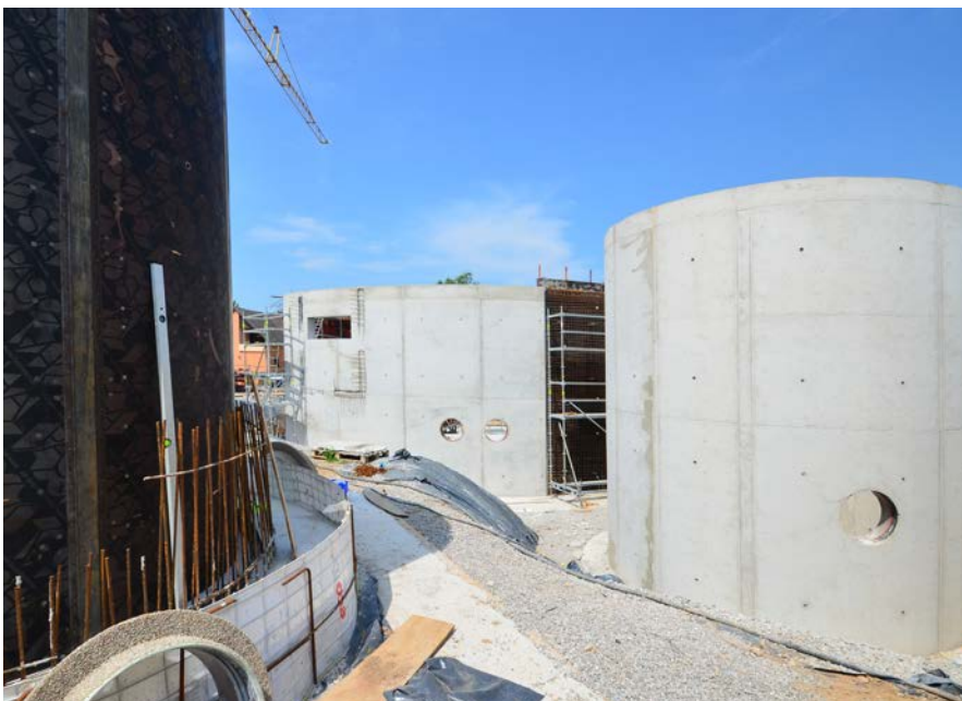
Klärwerk, Seesen; Bauunternehmung WBB Bau & Beton GmbH, Umpferstedt
