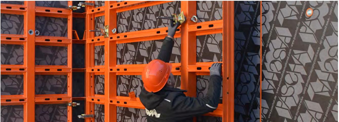
Die einseitige Ankertechnik ermöglicht die Bedienung der Schalungsanker mit nur einer Person.
