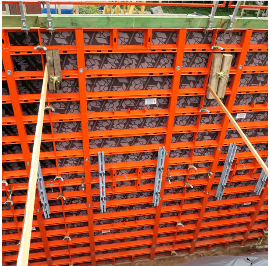
Herausdrehen des Spannstabes mit der Kugelgelenkplatte beim Ausschalen.
